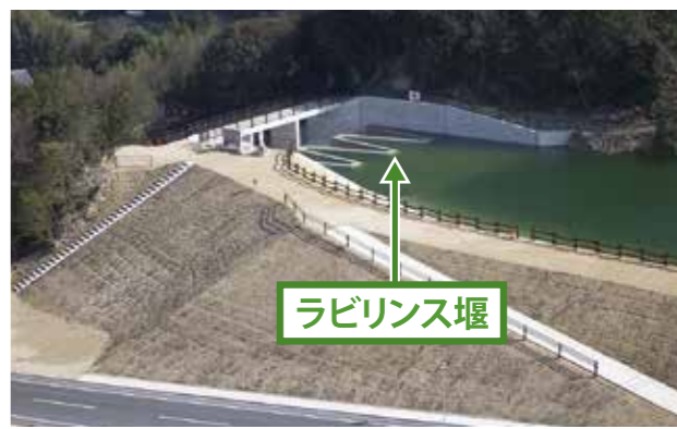
工事完成直後
