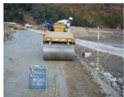
堤体の締め固め
