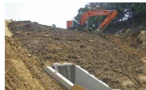
堤体の植生を復元するための作業
