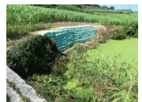
土のうによる崩落箇所の拡大防止
