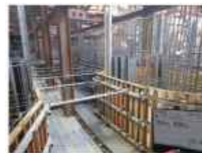
型枠組立状況
