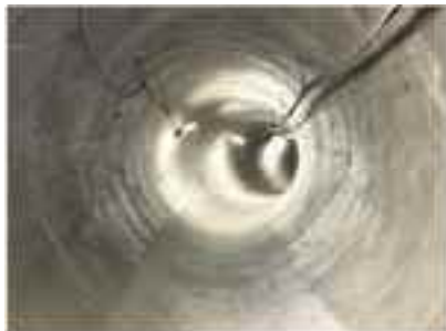
放水路内の様子 出典：ひめしおタイムス第9号
