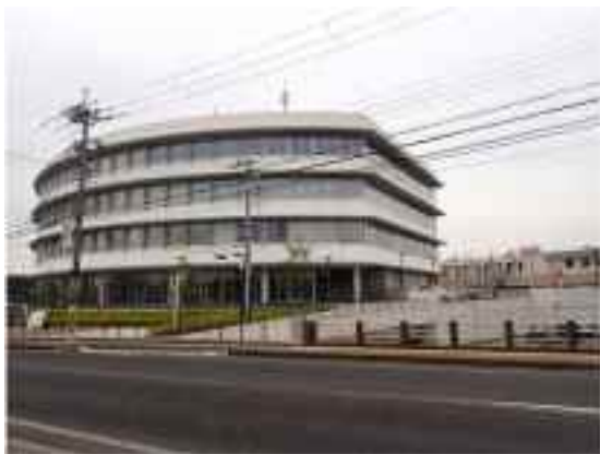
市役所新庁舎を盛土嵩上げ (高砂市)
