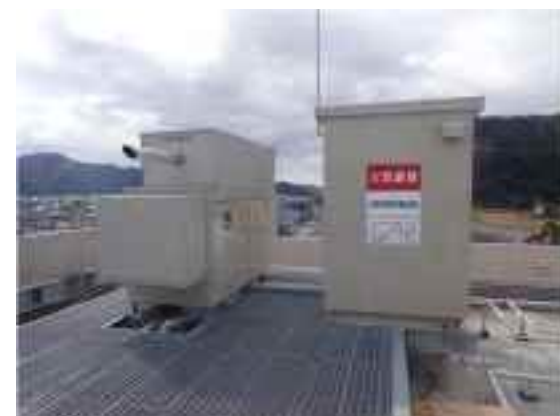
電気設備を庁舎屋上へ設置 (市川町)
