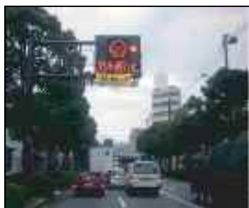
冠水情報板の設置
