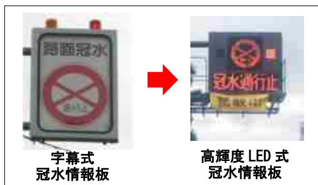
冠水情報板の高輝度 LED 式化
