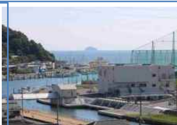
八家川排水機場
