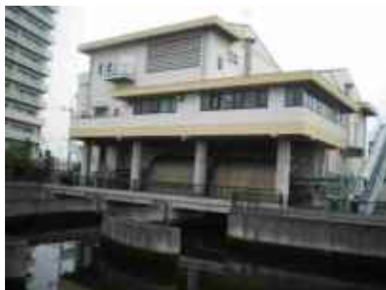
野田川排水機場
