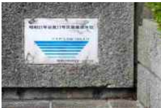
実績浸水深表示板 S51 災害・赤穂市役所
