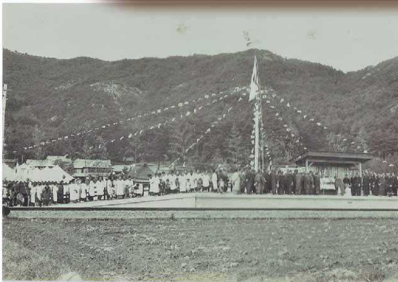
昭和10年 播但線 砥堀駅開業の様子
