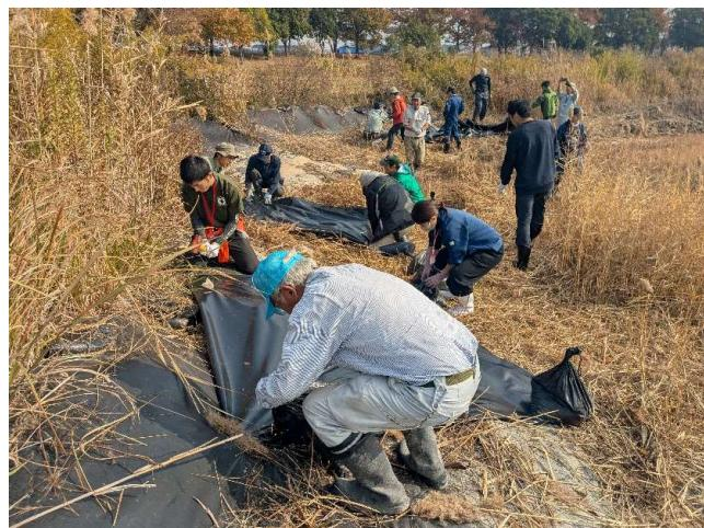
敷設した遮光シート間のわずかな隙間やシートの破れ目からの出現箇所も多く見られた。シート未敷設箇所同様に出現箇所を覆うようにシートを敷設する。結果として二重にシートを敷設することになる。水際は作業が難しい。
