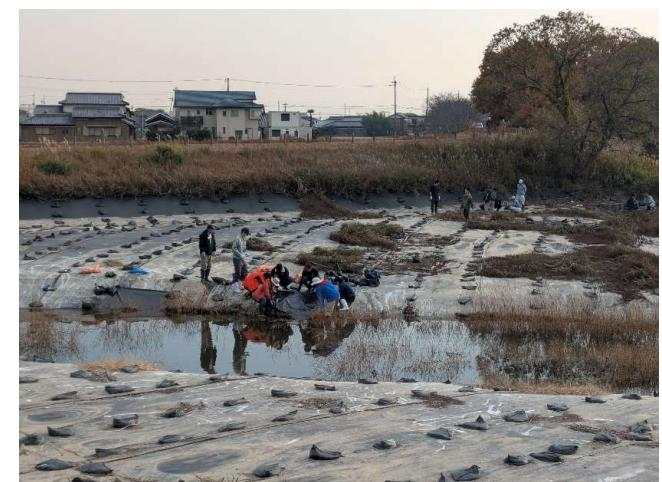
加古大池に入ってくる水が流れる水路「加古大溝」にも繁茂が確認されたため、抜き取りを行う。横のコンクリート階段の目地にも入り込んでいるため、後日目地止めを行うことに。
