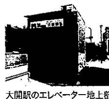
大開駅のエレベーター地上部
