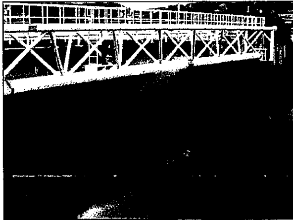
令和3年度：高砂市（第2天川橋水管橋）
