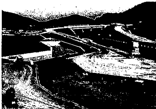
完成間近の宍粟JCT
