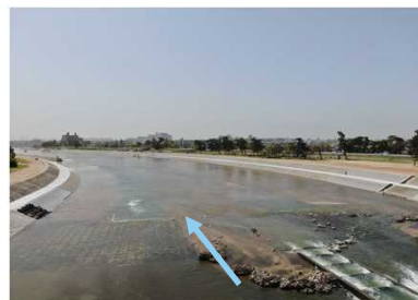
武庫川 河川改修
