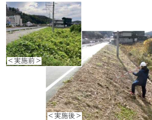
河川堤防の点検前除草
