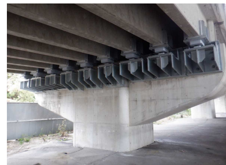
夙川橋 橋梁耐震 (芦屋市)
