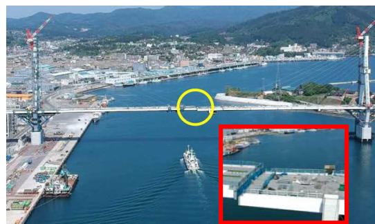
【橋桁接続の様子】
