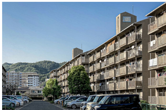
青木高層・鉄筋住宅
