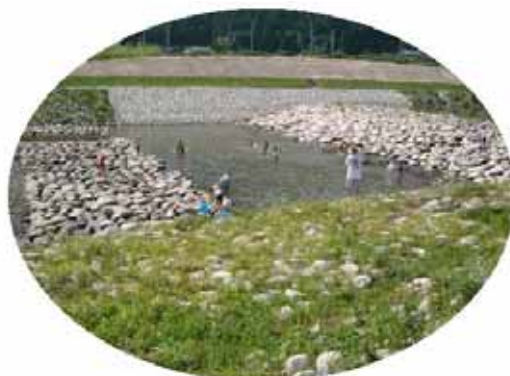
藍本（床止工周辺）
