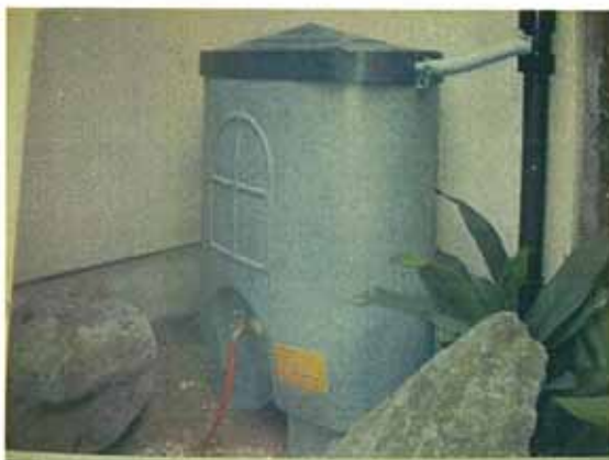
写真1 雨水貯留施設の設置状況
