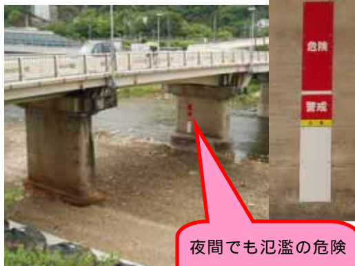
武庫川 生瀬橋 橋脚部
