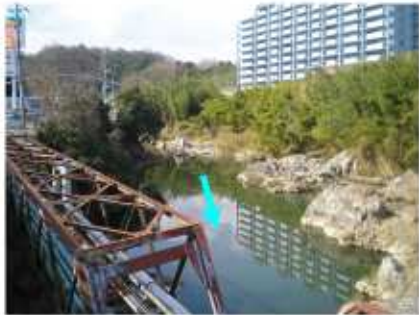
多田大橋より上流を望む
