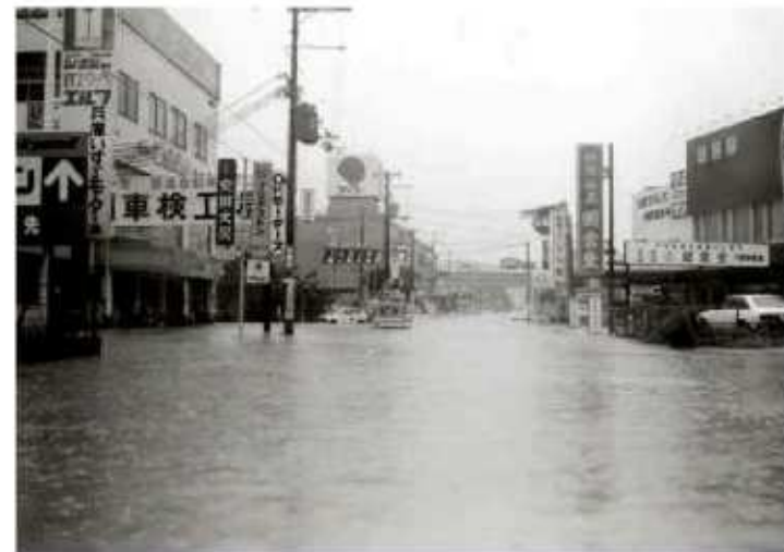
川西市多田桜木1丁目の浸水状況
