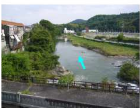
多田大橋より下流を望む
