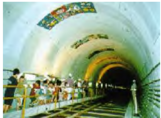
施設(貯留管)の内部
