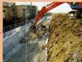
並べた石を固定するため、石の上にかゴマットを置き、中におもりとなる石を入れます。
