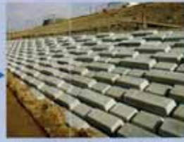
覆土ブロック設置後の状況
