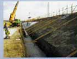
堤防の内部に侵食防止のための覆土ブロックを設置します。
