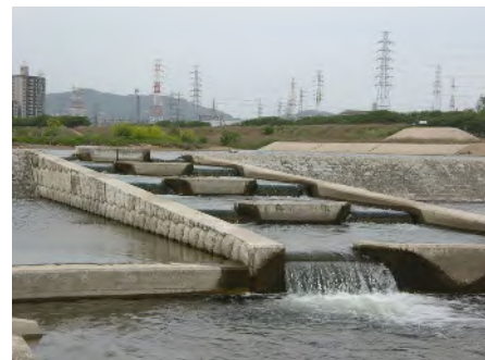
写真 2.2.24 床止めに設置された魚道
