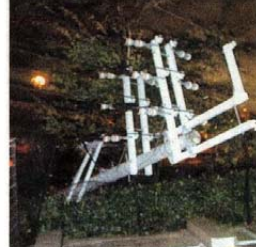
道路崩壊で倒れた電柱（午後8時15分ごろ、西宮市生瀬(武庫川側)で）
