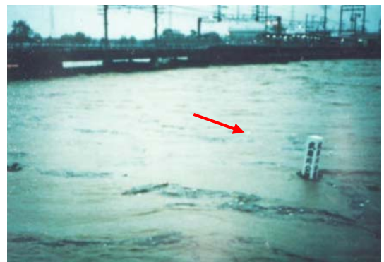
写真 2.1.7 昭和58年台風10号による洪水の状況（阪神電鉄橋梁付近）
