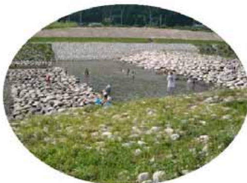
藍本（床止工周辺）
