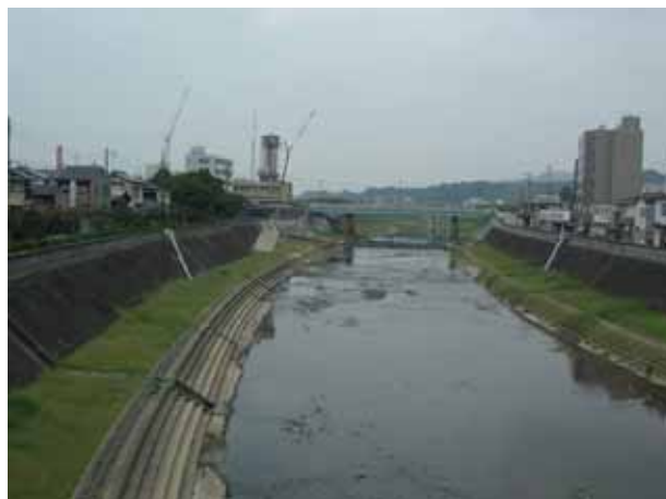
車瀬橋より武庫川上流 両岸の高水敷と階段護 岸、周辺の街並みを望 む
