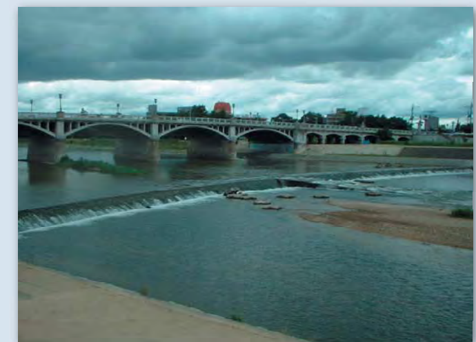
武庫大橋下流の堰
