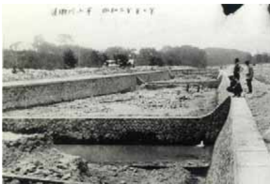
図 4.3.5 流路工施工後の昭和初期の逆瀬川
