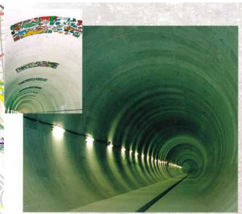
施設（貯留管）の内部
