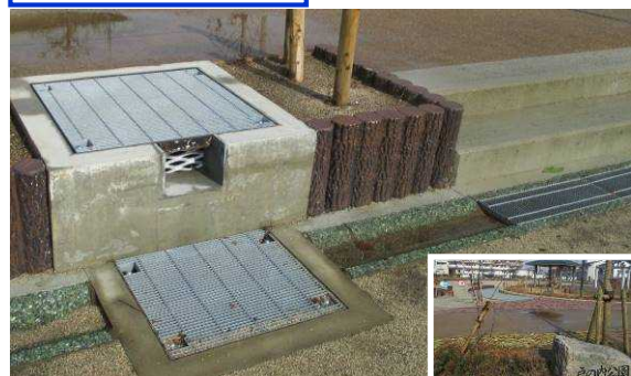
【公園貯留】 戸の内公園(尼崎市)
