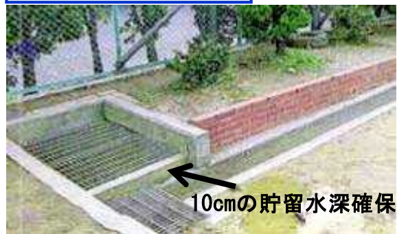
【校庭貯留】川西南中学校
