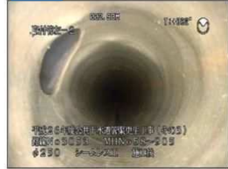
公共下水道管の管渠更生工事
