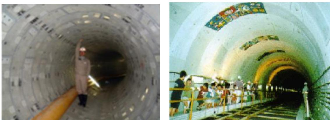
図 3-5 雨水貯留管（左：西宮市、右：伊丹市）
