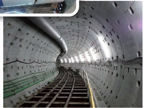
令和5年10月シールドマシンによる掘削完了
