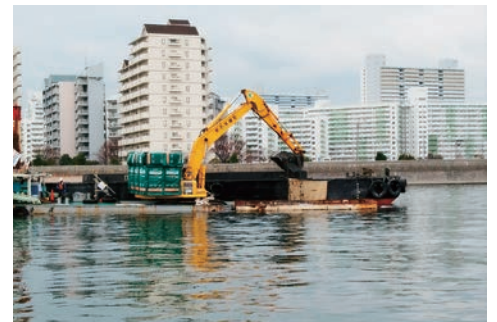
武庫川 河床掘削(臨港線下流)
