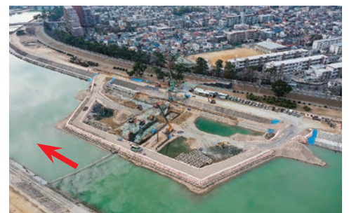
武庫川 1号床止工撤去工事
