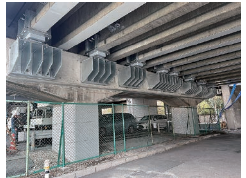
久々知陸橋橋梁耐震補強工事(尼崎市)
