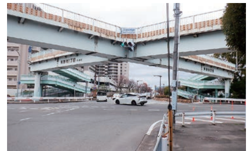
県道米谷昆陽尼崎線 芦原歩道橋 (尼崎市)
