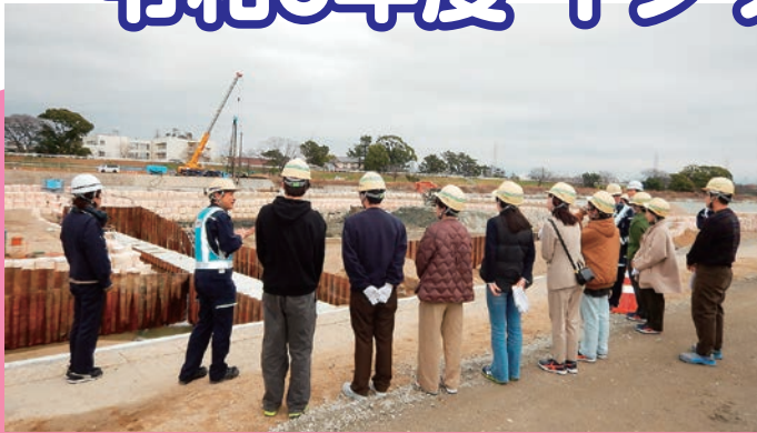
武庫川 工事現場見学会
