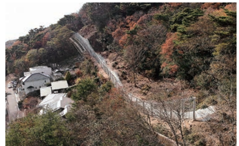
奥池 急傾斜地崩壊対策工事(芦屋市)
