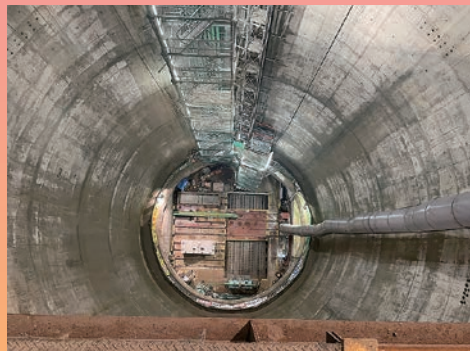
津門川地下貯留管 放流立坑
