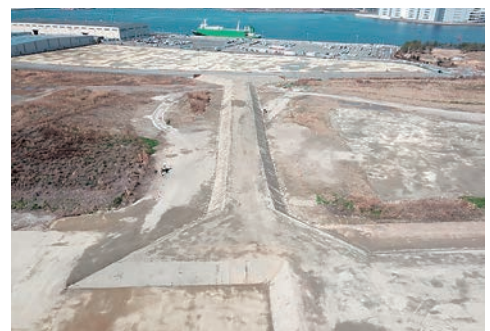
尼崎西宮芦屋港 臨港道路整備(尼崎市)
