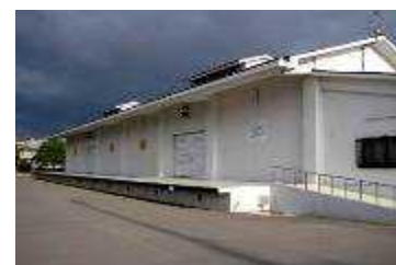
【阪神南広域防災拠点備蓄倉庫】
