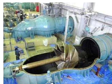
【東浜排水機場(ポンプ)の分解整備】
