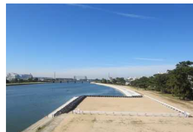
【武庫川低水路拡幅工事】
