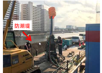
※防潮堤に隣接する遊歩道から地盤改良工事を実施
