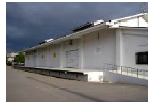
阪神南広域防災拠点備蓄倉庫
