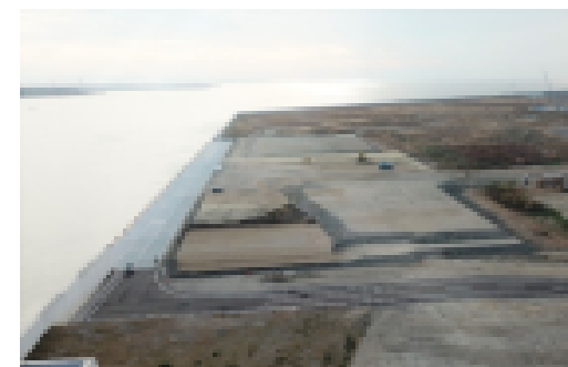
-5.5m岸壁（ふ頭用地）
