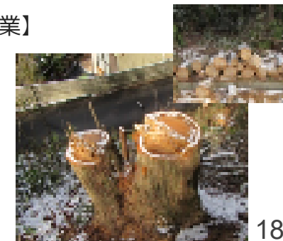
ナラ枯れ枯損木の伐倒・集積
