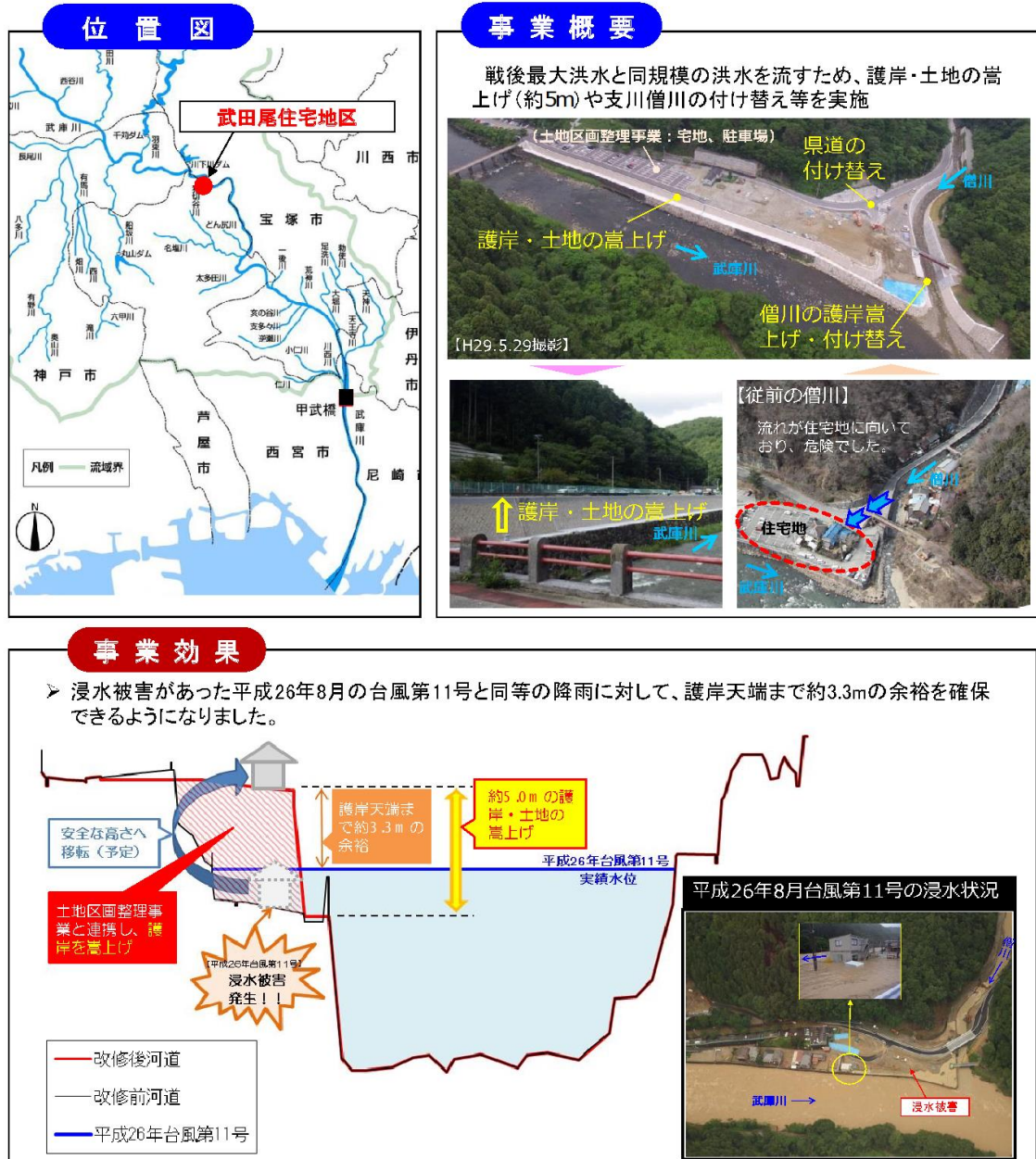
図 3-1 武庫川（武田尾住宅地区）の河川改修
