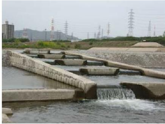
図 2-8 床止めに設置された魚道
