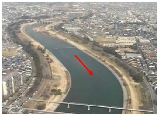
図 2-3 下流部築堤区間
