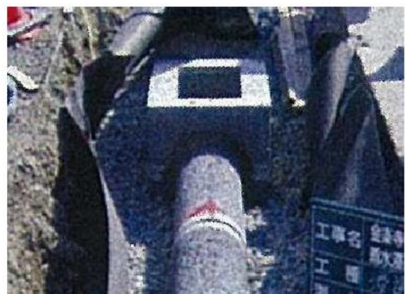
図 3-21 その他の雨水貯留・浸透の取組 （左：雨水貯留タンク、右：浸透管・浸透柵）
