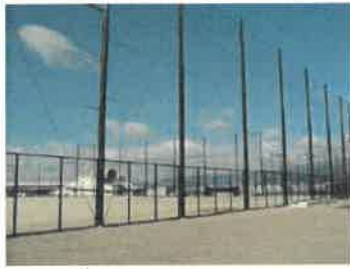
供用中の野球場（丸島地区）
