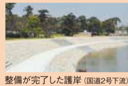
整備が完了した護岸(国道2号下流)
