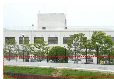
浸水防止用擁壁（船津浄水場）
