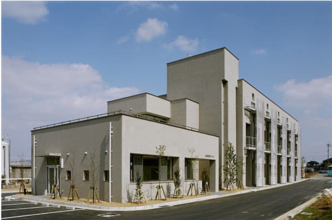
水質管理センター全景
