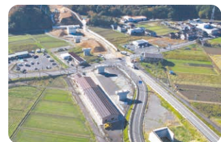
山陰近畿自動車道 浜坂道路II期のトンネル工事等を実施(写真は新温泉浜坂ICの建設状況)。
