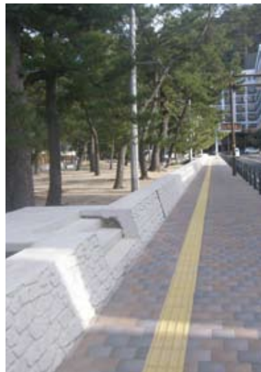
▲洲本地区 防潮堤の越流対策
