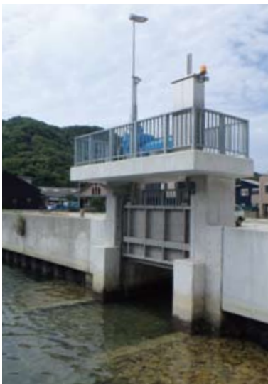
▲福良港 防潮堤の整備(樋門などの自動化)
