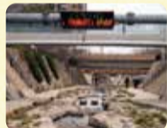
河川増水警報システムの電光掲示板
