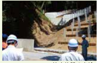
治山施設の点検
