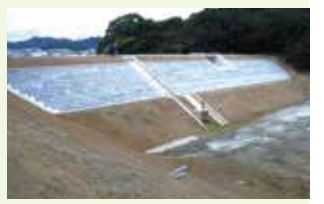
改修された北谷池(南あわじ市)
