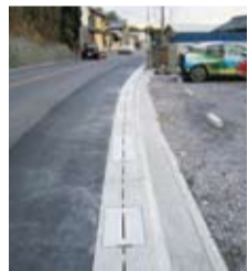
側溝にふたをして安全に(淡路市野島)
