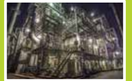
兵庫東スラッジセンター 夜景(写真:小林哲朗さん)
