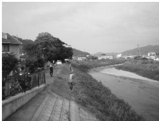
【洲本川堤防草刈り】
