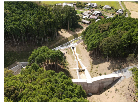
赤松川 砂防堰堤 (加西市)
