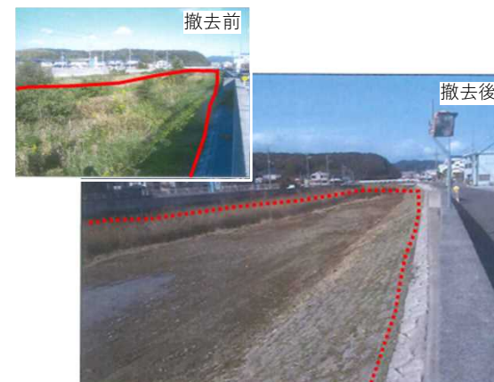
千草川 堆積土砂撤去（洲本市）
