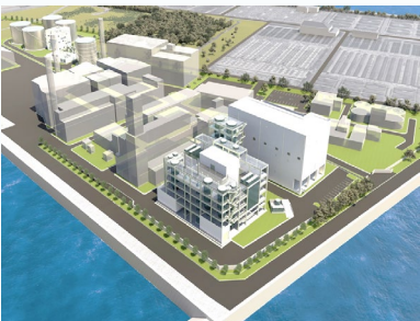
下水汚泥広域処理場でのバイオガス生成や下水汚泥の固形燃料化
