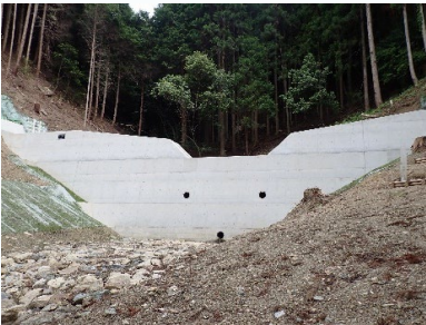
土砂災害防止施設（治山ダム）の整備
