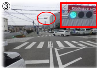
③ 貴布祢神社北西 交差点信号機 LED化(尼崎市)
