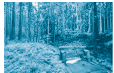
災害緩衝林と簡易流木止め施設
