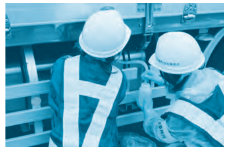
軽油抜き取り調査の様子
