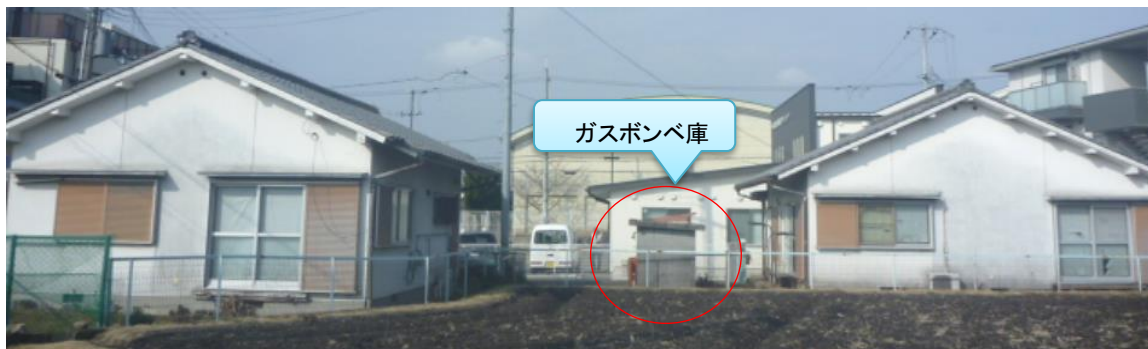
(3号公舎) 南西から北東向きに撮影
