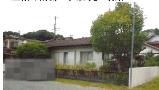
(全景3) 南側から北向きに撮影
