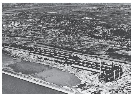
写真 32 神戸製鋼所加古川厚板工場 (神戸製鋼所提供)
