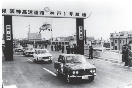
写真 82 阪神高速道路（京橋～柳原間） 開通式（神戸市提供）
