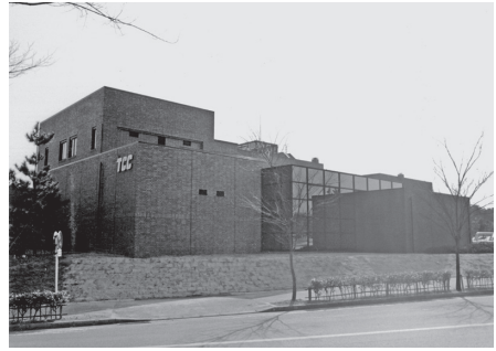
写真 53 滝野ケーブルコミュニケーション局舎（加東市提供）
